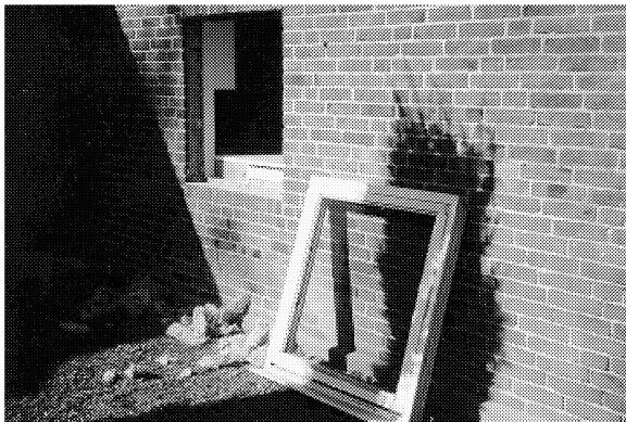
Figur 8.20 Fönster nr 3 är ett 1-lufts 3-glasfönster tillverkat år 1982.
