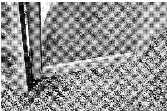
Figur 8.4 Ytterbågarna har inga rötskador.
