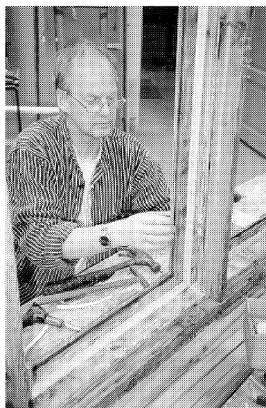
Figur 8.12 Ny anslagslist monterades. Som tätning limmades en slanglist av silikongummi.
