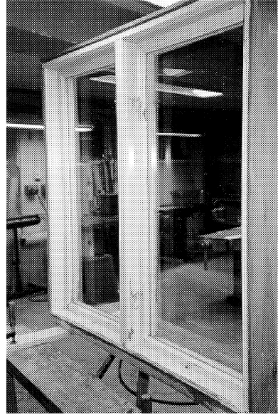
Figur 8.17 Bågarna är sidohängda i lyftgångjärn och låsta med kopparbeslag och stängda med fönsterhasp.
