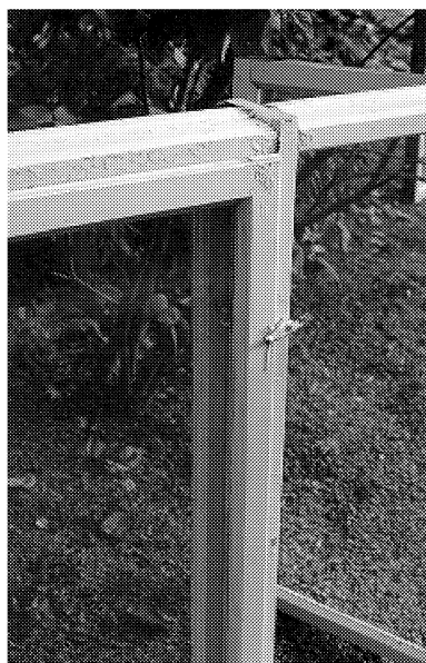
Figur 8.2 Överfalsade innerbågar utan gångjärn.
