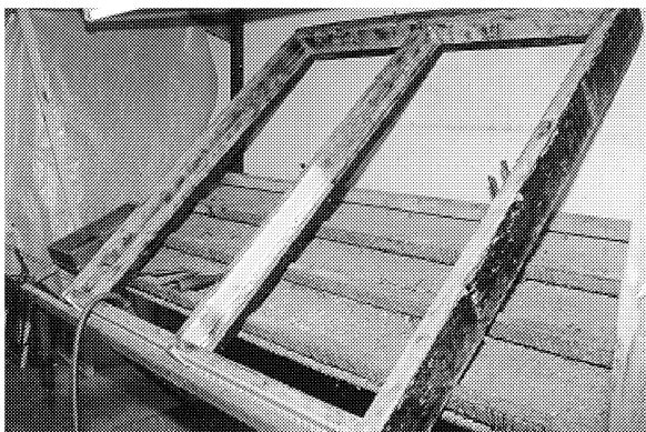
Figur 8.8 Färgborttagning med hetluft.
