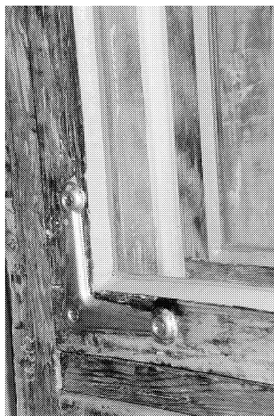
Figur 8.13 Detalj av återglasade bågar.
