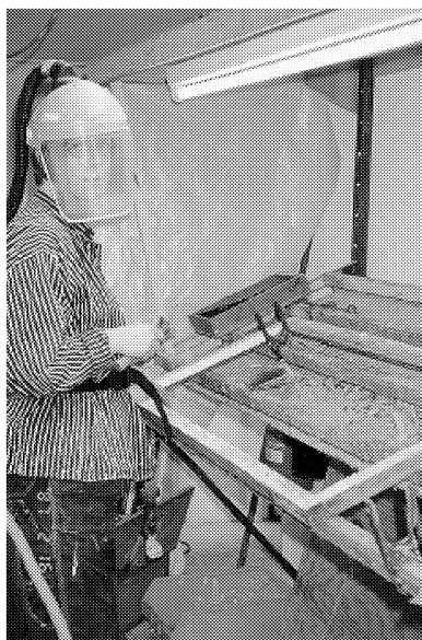
Figur 8.9 Färgborttagning med betluft.
