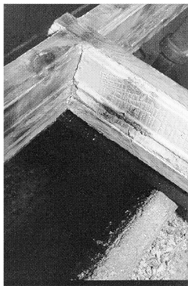
Figur 8.10 Färgborttagning med betluft.
